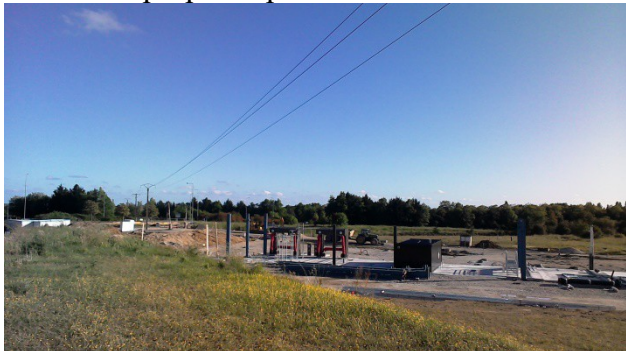
La station-service en plein champ et en plein confinement (photo du 5 mai 2020)
